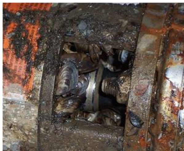
Рисунок 2 – Блокировка насоса
