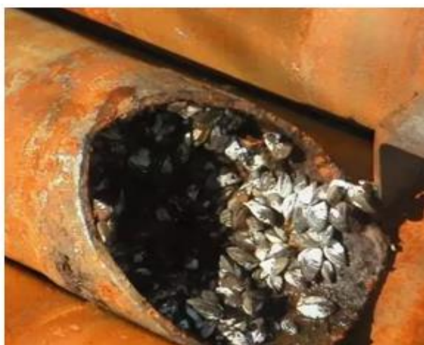
Рисунок 1 – Засоренная труба
